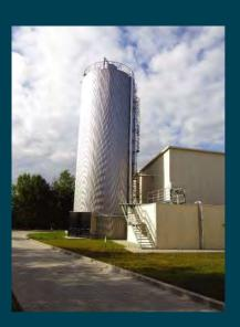
Реактор ECSB - реактор со взвешенным слоем анаэробного ила и восходящим потоком жидкости.
