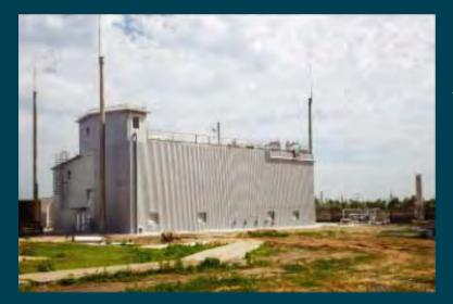
Реактор UASB - с взвешенным слоем анаэробного ила и восходящим потоком жидкости. Реакторы UASB работают с более низкой . удельной нагрузкой по ХПК приведенной к рабочему объему реактора, но при этом могут иметь большую производительность. Реактор UASB оборудуются одним уровнем 3-фазных сепараторов. Цель таких сепараторов - отделить очищенные сточные воды от биогаза и анаэробного ила. В процессе анаэробной очистки происходит выработка биогаза, содержащего до 70% метана.
